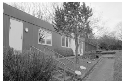
som bliver grundigt renoveret
