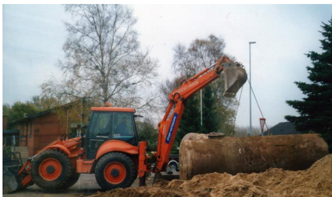
Tankene til benzin- og dieselprodukter bliver gravet op og fjernet fra Grindsted Autoværksted. Foto: Inga & Kjeld Bislev
