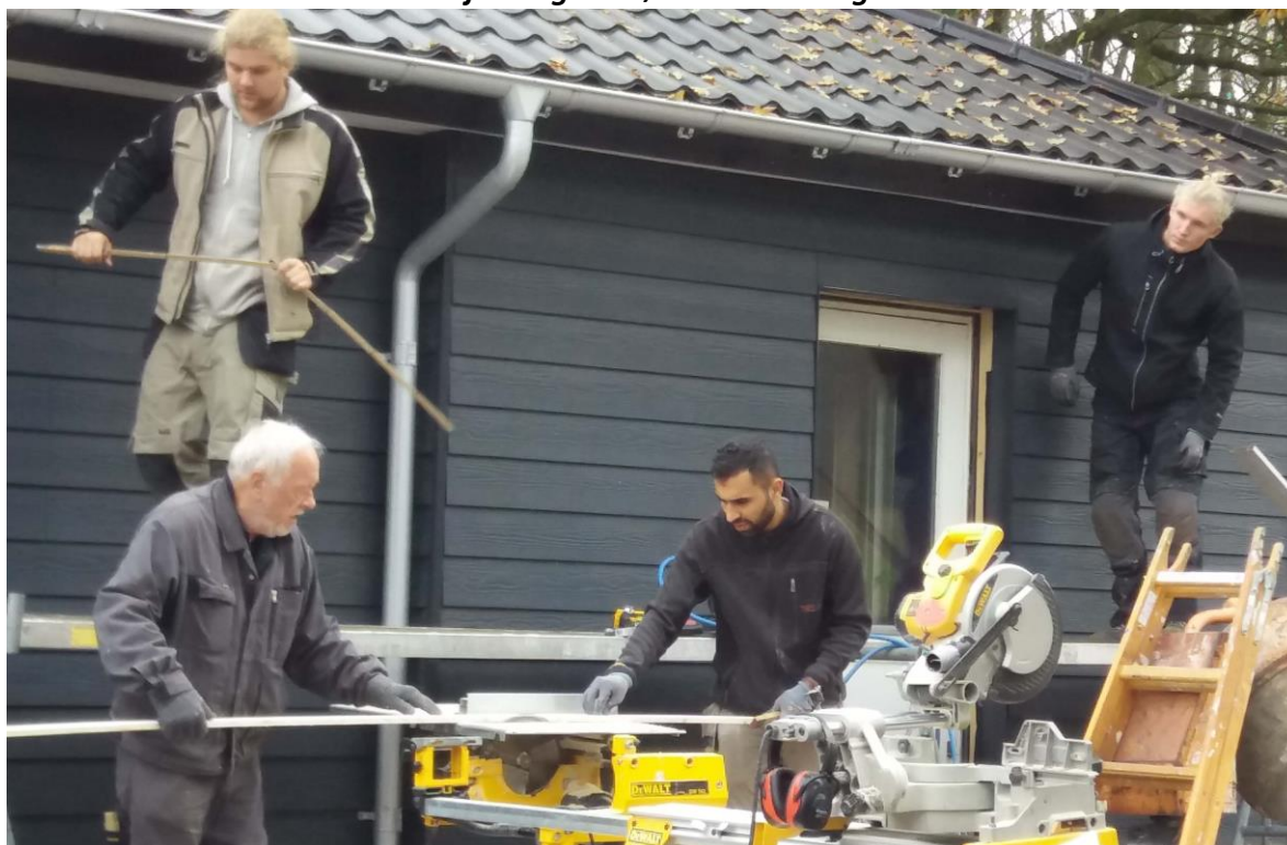
Finn og tømrerlever monterer sidste del af husets facadebeklædning.
