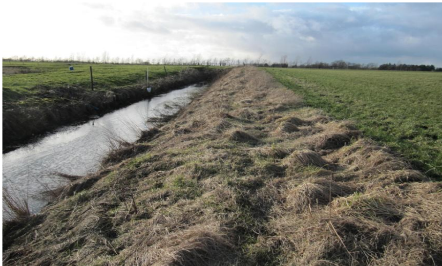
Møgelkærgrøft set mod dens vestlige begyndelse, den fortsætter her i den rørlagte Hammergårdsgrøft. Møgelkærgrøft begynder her sit "afvandingsløb" mod øst. Det var i området mellem grøftens begyndelse og markvejsovergangen, der ses på næste foto, at blev uroksehornet fundet i 1954. Foto Poul Dahl
