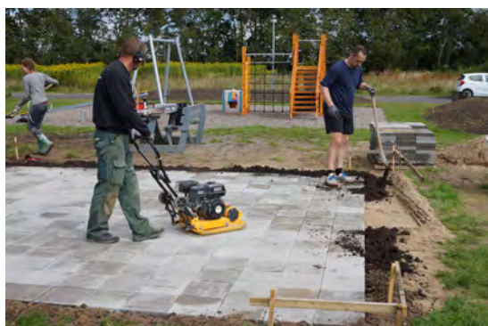
Et godt fundament er vigtigt!
