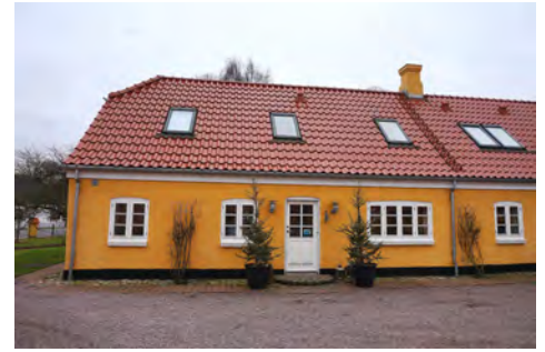
Hovedbygning efter reovering
